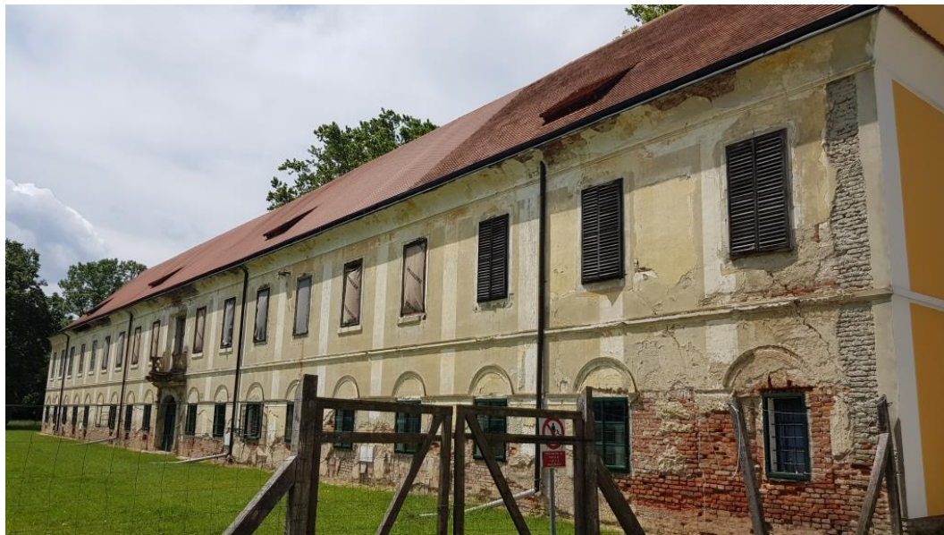
Prikaz 18 KD „Dvor Draškvić“ – neuređeno pročelje, stanje lipanj 2020.
